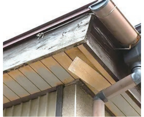
雨樋の詰まりや周辺補修
