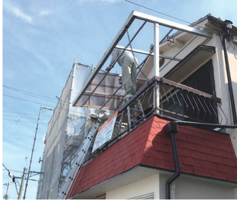
波板屋根の老朽化
